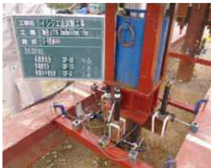
写真4 くい頭部変位計
