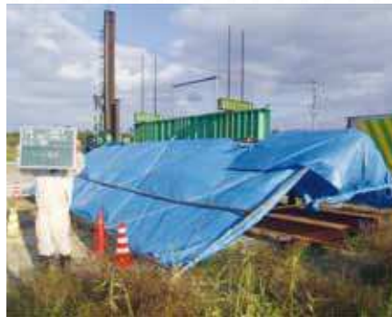
写真2 載荷装置養生状況
