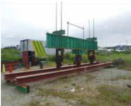
写真1 載荷装置組み立て
