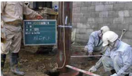
杭芯位置確認
